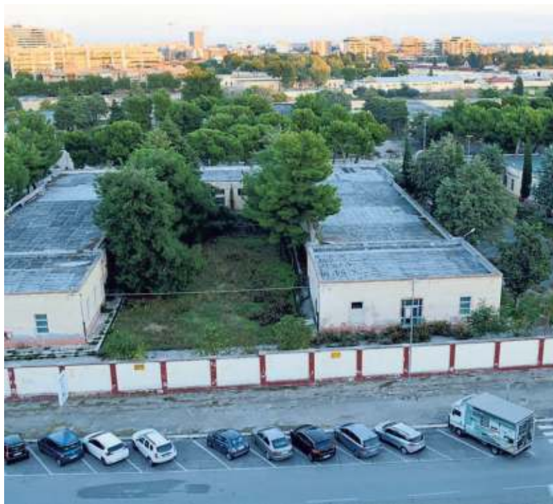
▲ Le ex Casermette L'area sulla quale sorgerà il Parco della giustizia
